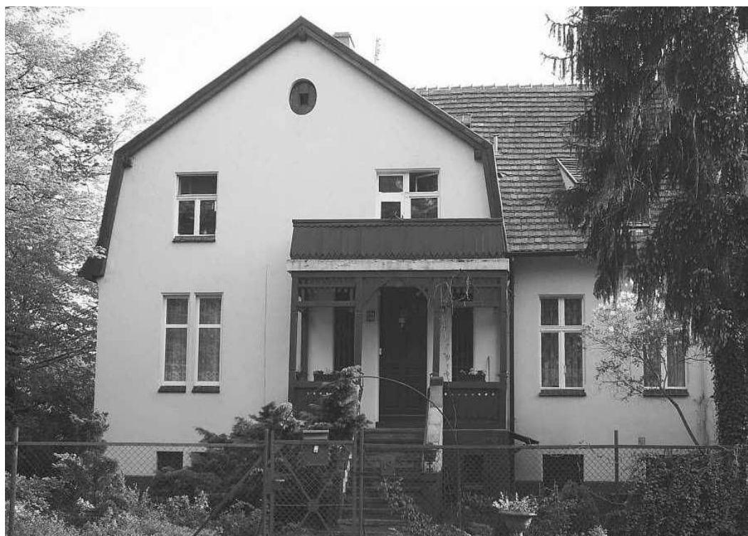
Dom przy ul. Dembowskiego 19, w którym mieszkał prof. Rybka w latach 1945-1958 (stan obecny).
