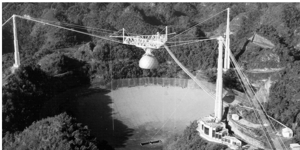
Radioteleskop w Arecibo z lotu ptaka. W centralnej części ponad czaszą widoczna platforma, podtrzymywana na linach wspartych na trzech pylonach. ( Courtesy of the Arecibo Observatory, a U.S. National Science Foundation facility )
