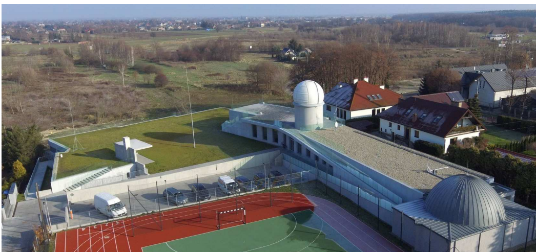
Widok ogólny na MOA po modernizacji.
