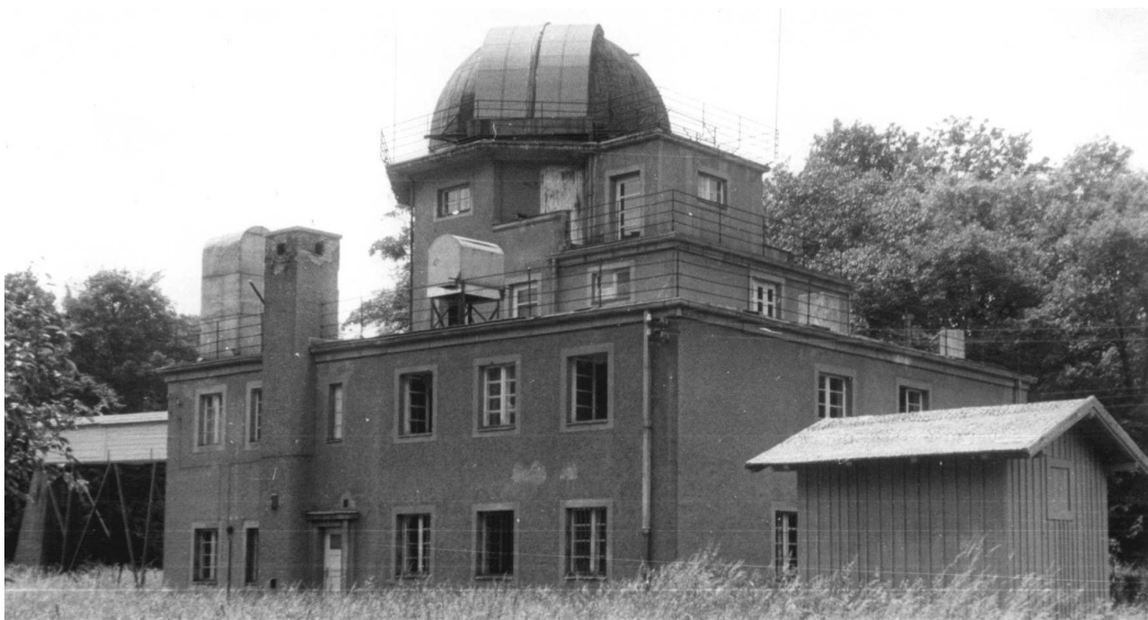
Główny budynek Obserwatorium Astronomicznego Uniwersytetu Wrocławskiego przy ul. Kopernika 11.
